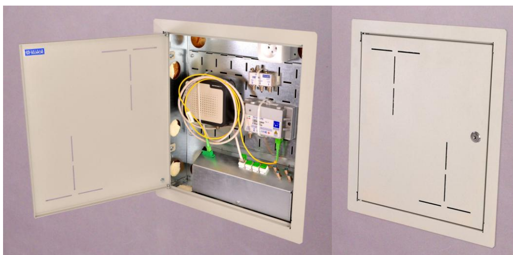
Przykład zamontowanej szafki TeSM-101 wraz z wyposażeniem
