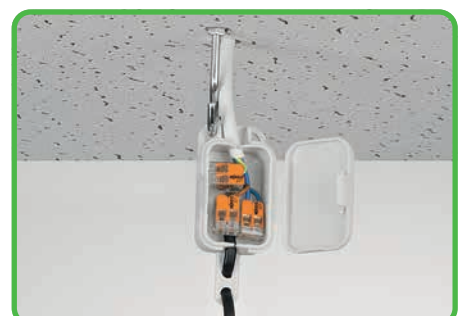
Montaż lamp wiszących w podwieszanym suficie
