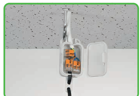
Montaż lamp wiszących w podwieszanym suficie
